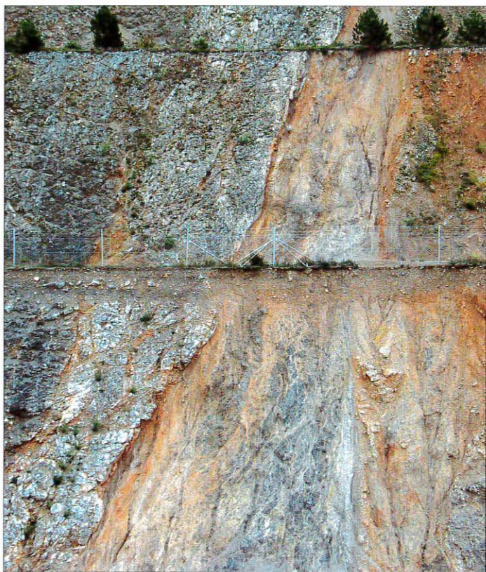
Sl. 2.12. Presek prelomne cone regionalnega desnozmničnega Raškega preloma v avtocestnem useku pri Senožečah. Ta prelom s smerjo severozahod-jugovzhod je še danes seizmično aktiven. Dobro je vidna kataklastično zdrobljena notranja prelomna cona s spremljajočo porušeno cono na levi. Marko Vrabec
